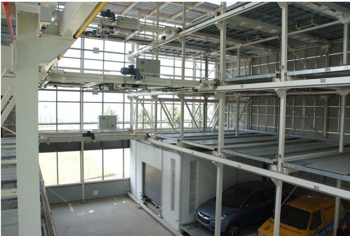
Obr. 2. Vnitřní uspořádání parkovacího domu.
