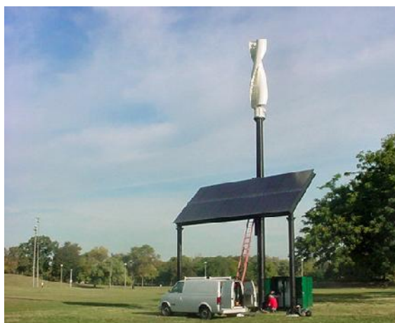
Obr. 9 Kombinace Savoniův rotoru se solárním systémem
